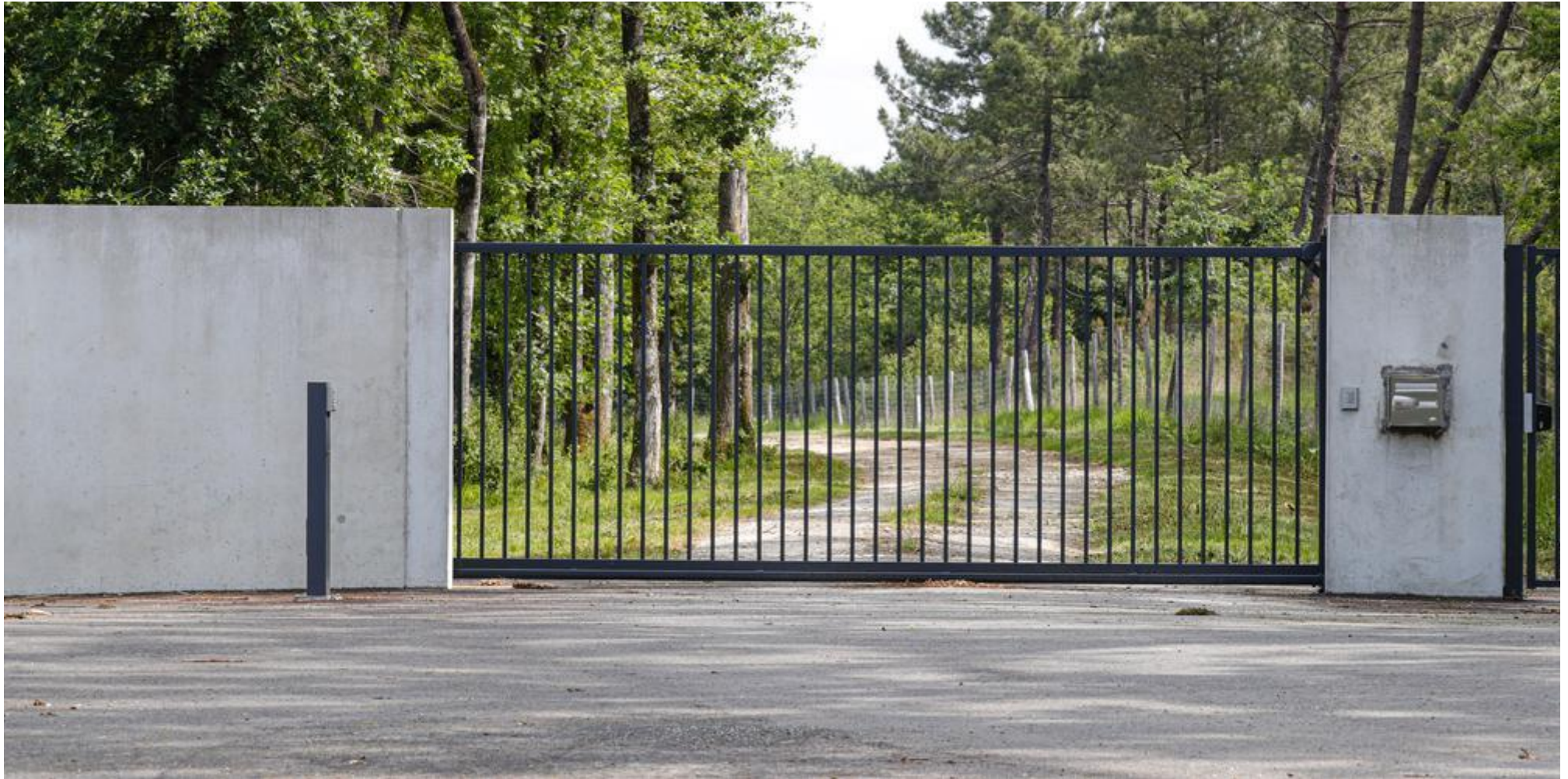
L'entrée de la propriété annonce plus un bunker qu'un havre de paix de 30 hectares. © Crédit photo : Jean-Christophe Sounalet / « Sud Ouest »
